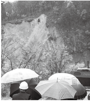
国道156号秋町の崩壊現場
