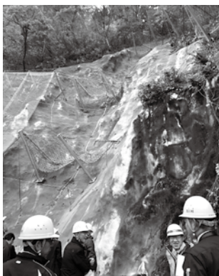
雪崩対策が施工される 村道下田内ヶ戸線
