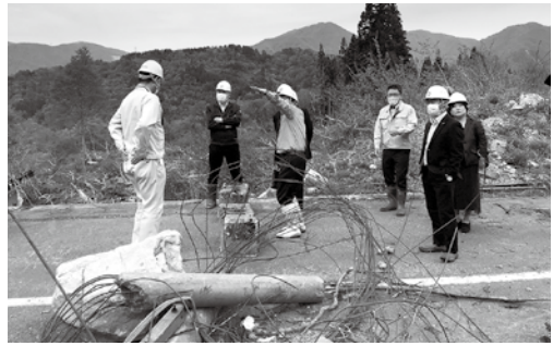
5/12 馬狩地区雪崩被害状況視察
