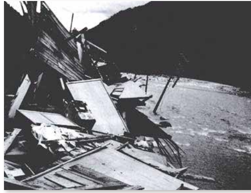
平瀬地内 庄川の氾濫
