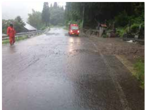
稗田地内 村道への流水 (川本ポンプ前)
