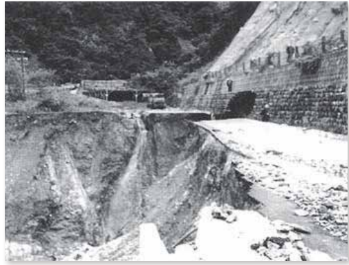
牧地内 不動谷氾濫による国道156号の決壊
