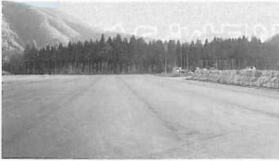
▲寺尾駐車場整備に着手しました
