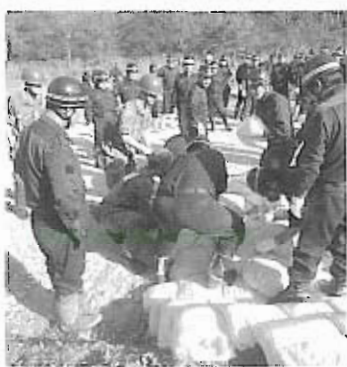
⑤自衛隊指導のもと、消防団が3班(土のう作成班、運搬班、積み上げ班)に分かれ、法面を河川にみため、土のう積みによる護岸保護作業
