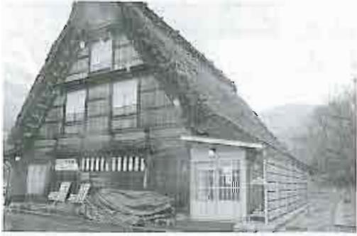
▲総合案内であいの館の改修を行いました
