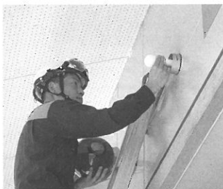
LEDへの取替え作業
