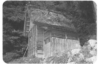
佐藤正利家板倉(修理前)
