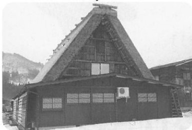
高橋兼明家主屋(修理後)
