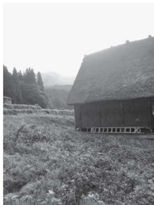
復旧前の状況
