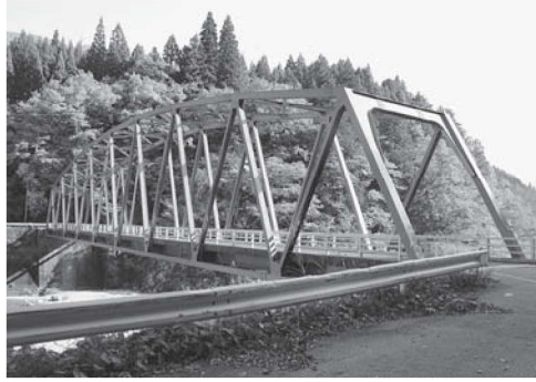
▲木谷橋補修事業
