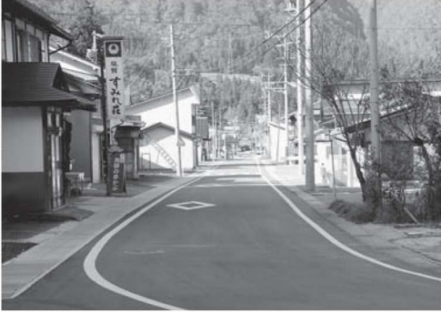
▲村道荻町鳩谷線舗装側溝改修事業
