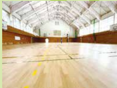
床を全面張り替えたフローア
